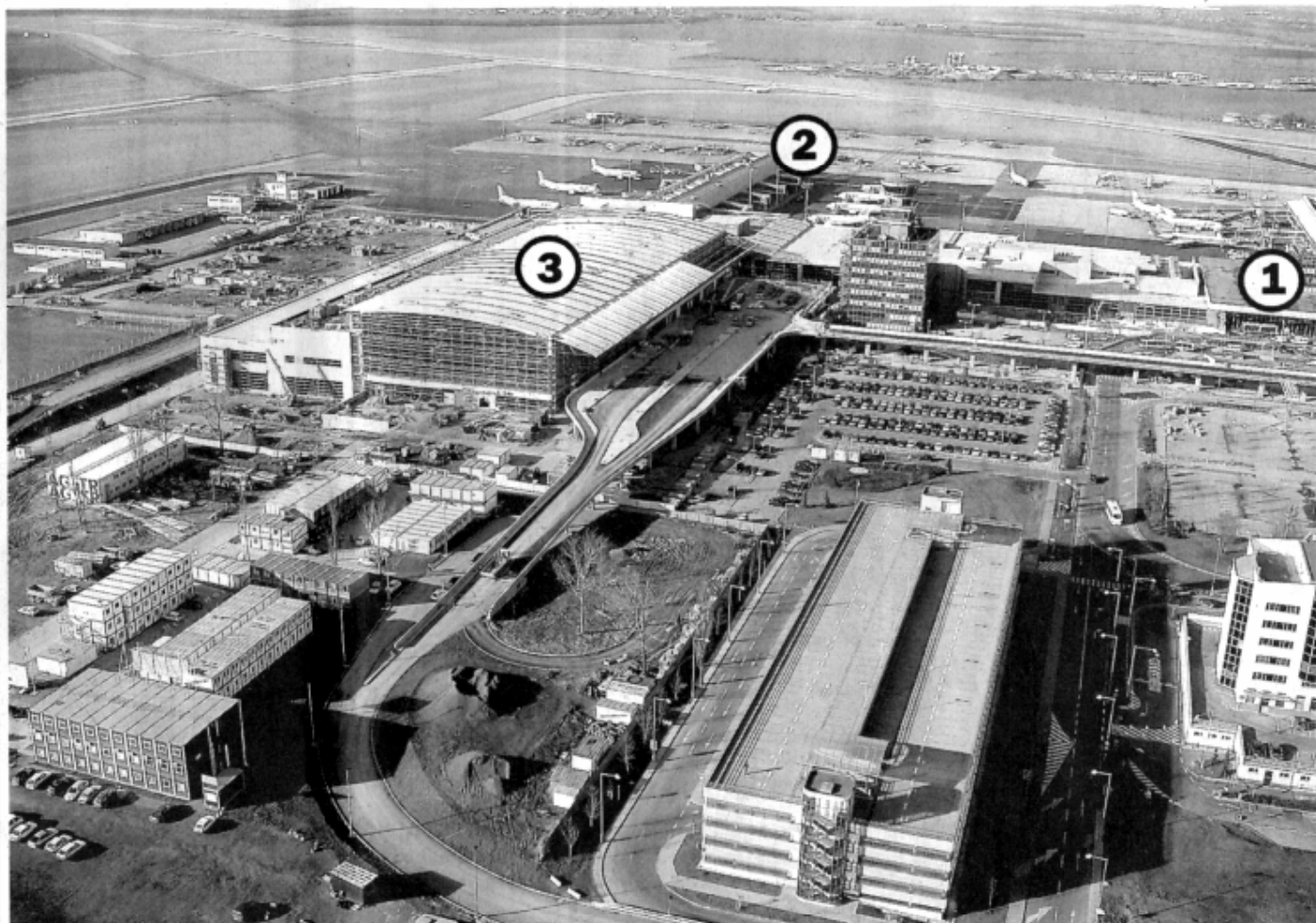
NOVÁ RUZYŇ. Mezinárodní letiště v Praze dokončuje svou rozsáhlou expanzi. K původním halám (1) v září přibude prst C (2) a pak i obří odbavovací hala s dvoupatrovou silnicí (3). FOTO: SKANSKA
