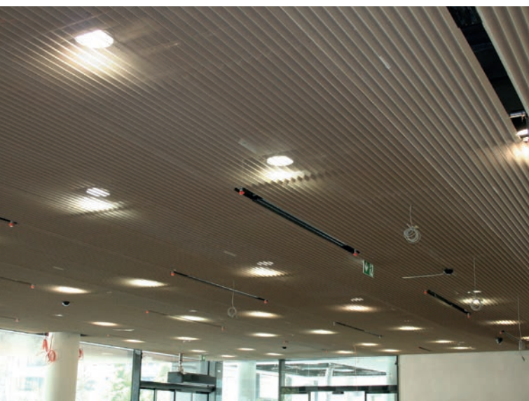
Podhled v lobby
