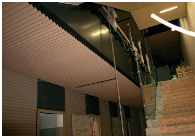
Podhledy a obklady na chodbách
