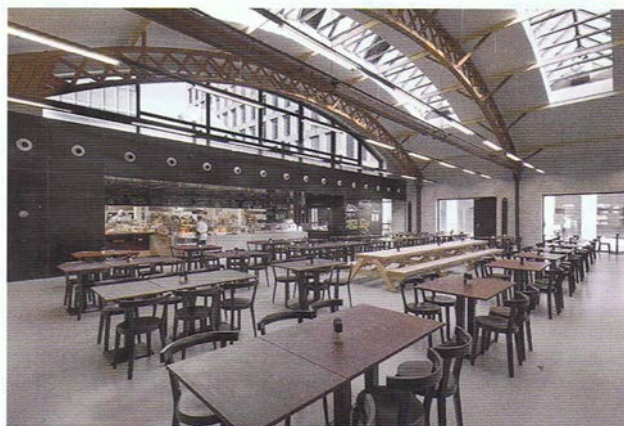
5 Repasované a doplněné dřevěné vazníky dochované v prostoru bývalé haly, kde dnes funguje restaurace.
