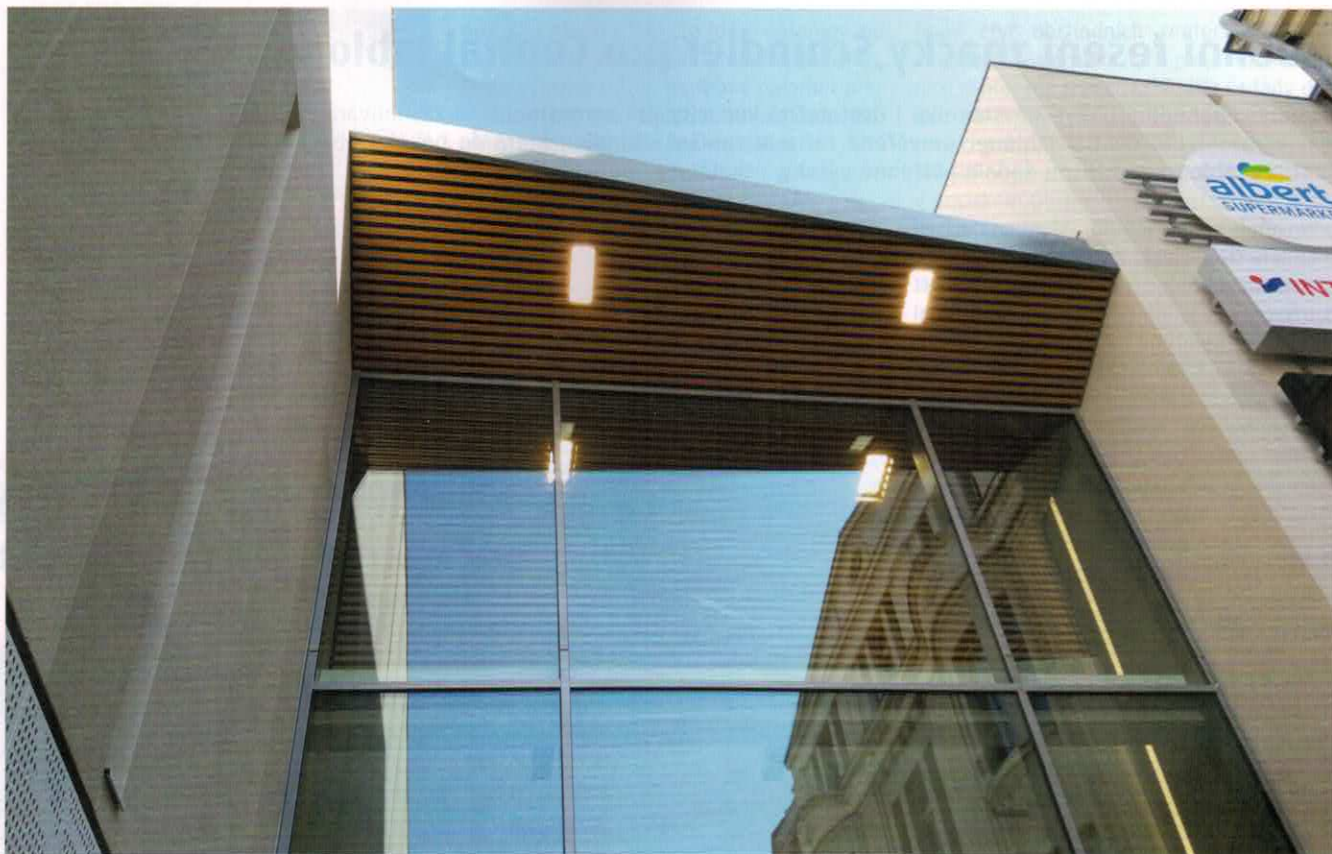
Exteriér s osazenými světly
