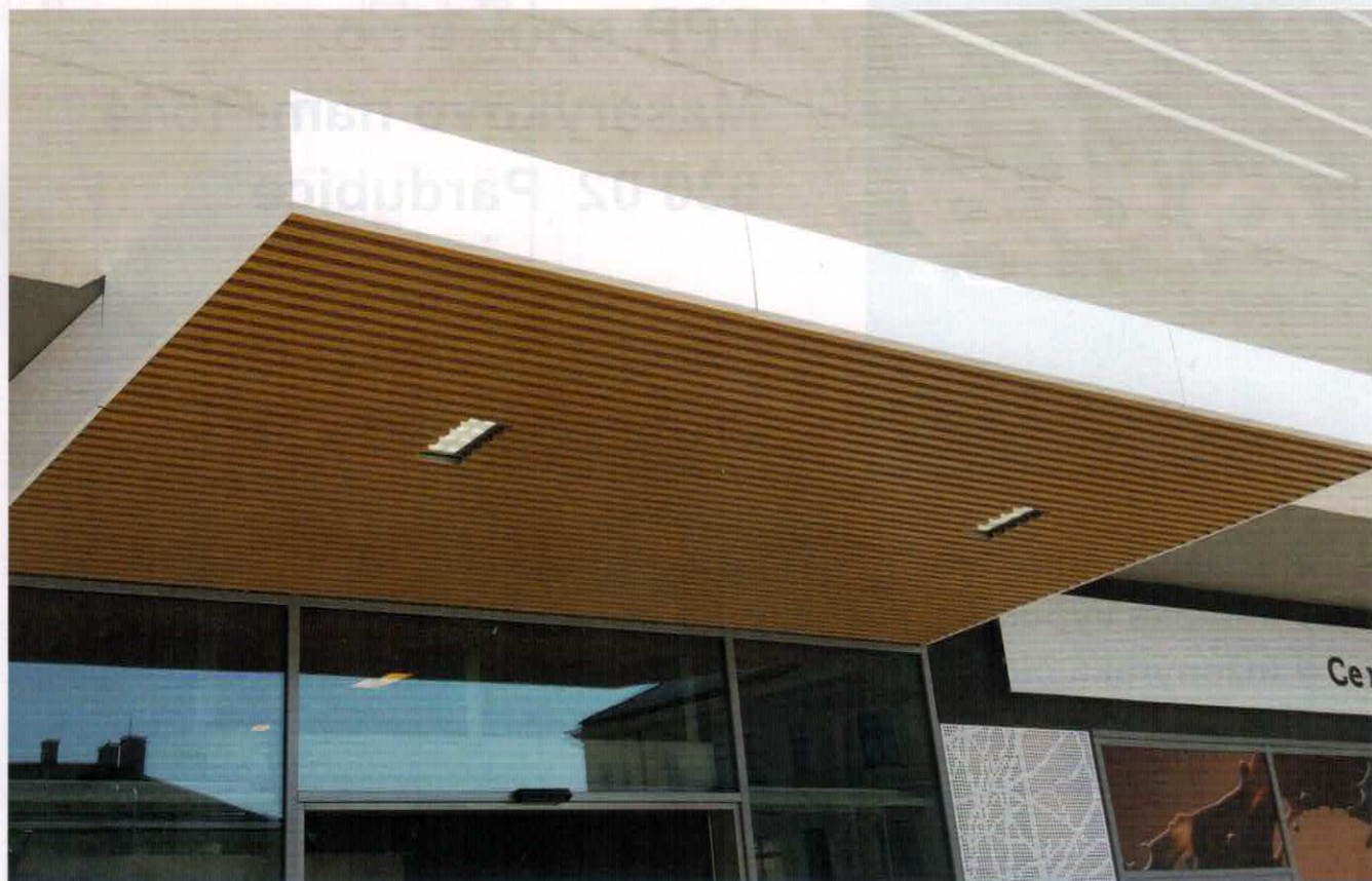
Trapézový plech – exteriér
