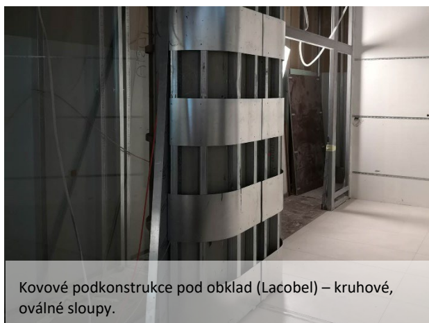
Obklad sloupu (Lacobel) na kovové podkonstrukci.
